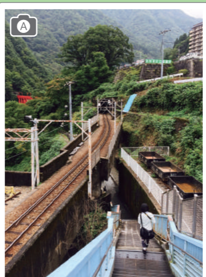
トロッコ電車の線路と歩道の立体交差
